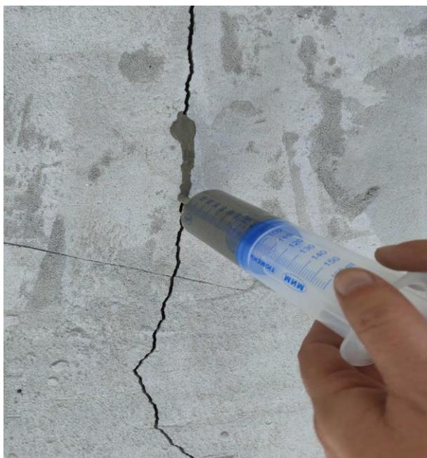
**Рисунок 5.3** – Инъектирование трещин ремонтным составом в натуральных условиях
